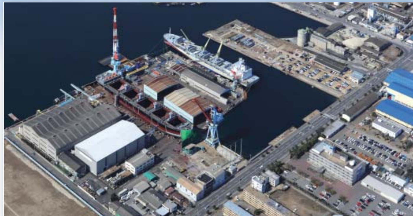
南東方向から撮影
